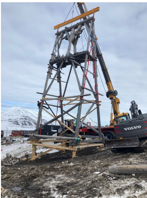
Sikring av taubanebukker (fredede kulturminner)
